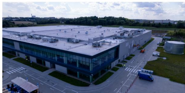
OBIEKT PRODUKCYJNY SIEMIANOWICE ŚLĄSKIE
