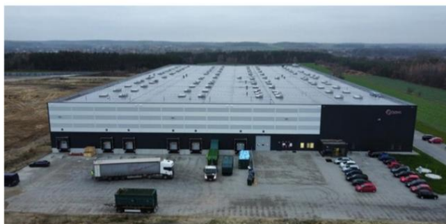
HALA MAGAZYNOWA W RAWIE MAZOWIECKIEJ
