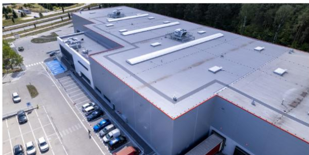
HALA PRODUKCYJNO-MAGAZYNOWA W ŁÓDŹ
