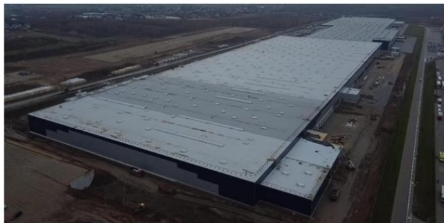
BUDOWA MEDIA EXPERT
