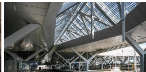
Fot 21 Zadaszenie Dworca Zachodniego w Warszawie modułami BIPV z funkcją NoFrost
