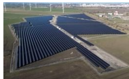
Fot 10 Klasyczne moduły PV na gruncie. Farma fotowoltaiczna
