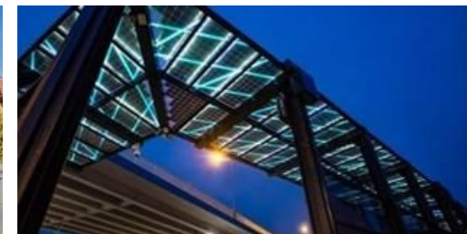
Fot 17 Luminescencyjne moduły BIPV z grawerem na zadaszeniu
